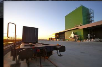
Spoor- en wegaansluiting op de site, maritieme diensten
